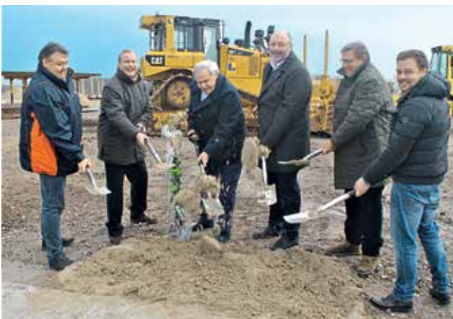
Beim Spatenstich (v.l.n.r.): Marcus Kohlhoff, Christian Punge, Uwe Kohlhoff, Johannes Blum (Althoff Industrie- und Verwaltungsbau GmbH), Joachim Punge und Daniel Kohlhoff.
